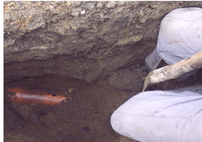
Handelsübliches KG-Rohr als Gasleitung
