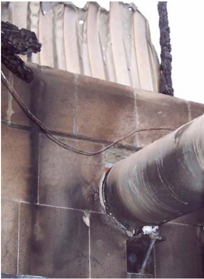
Brandschaden an einem BHKW-Gebäude
