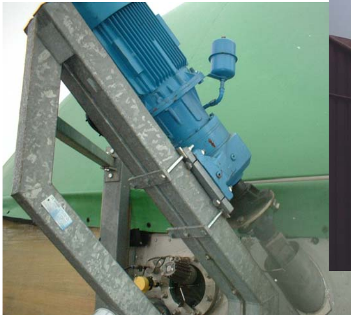
Gegen Schwingungen gesichertes Rührwerk
