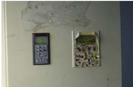
Schaden am Steuerschrank
