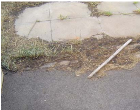
Brandspuren vor dem Gebäude
